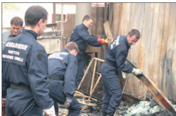
Investigations dans un bâtiment incendié.
